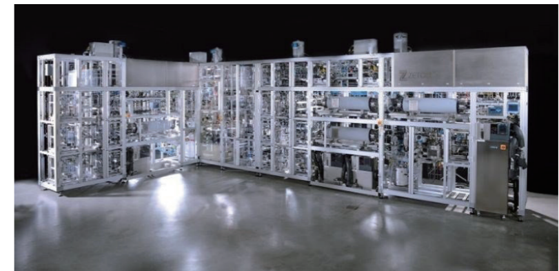
| 그림 8. GSK 사의 Continuous API Manufacturing Pilot Plant |
